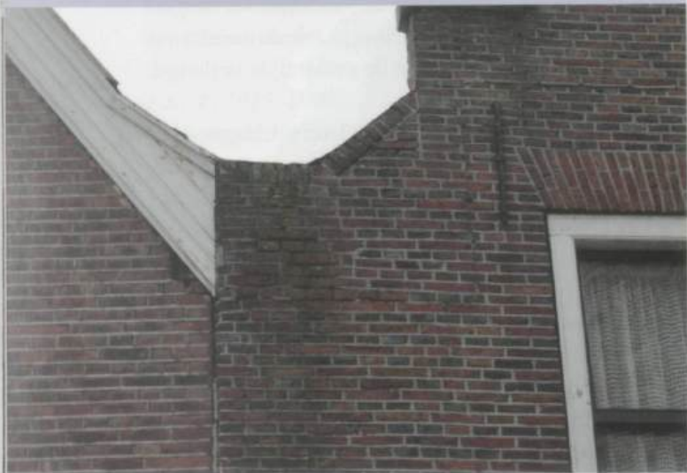
Detail voorgevel t.p.v. tussengoot
