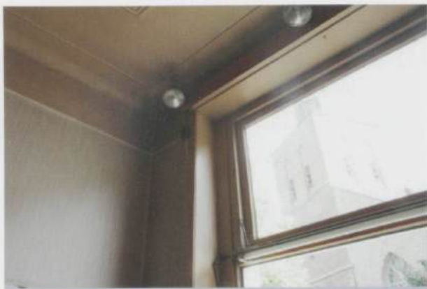
Voorkamer 0.2, detail raam voorgevel
