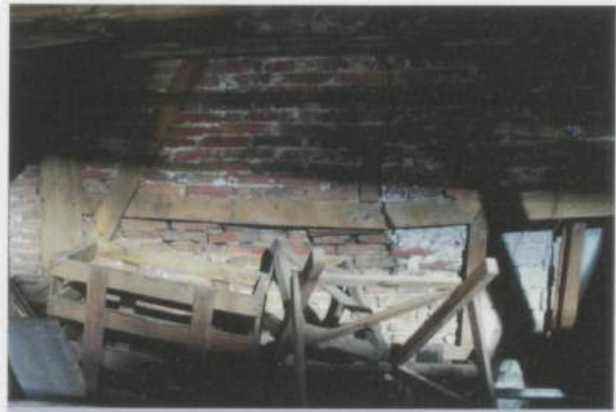
Oorspronkelijke linkerzijgevel t.p.v. achtergevel
