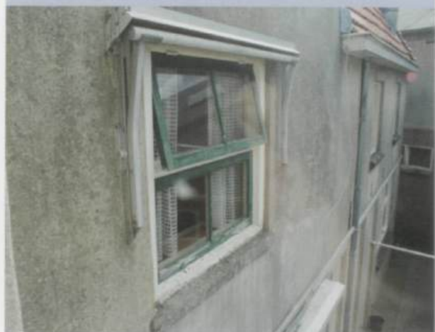
Raam verdieping achtergevel
