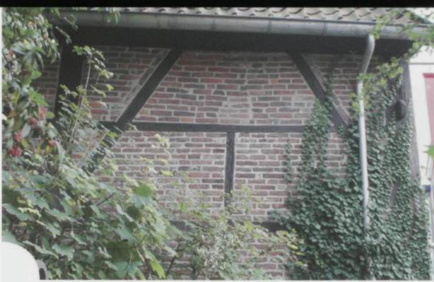
Linkerzijgevel schuur Nieuwestraat 20-22 Groenlo (foto auteur)
