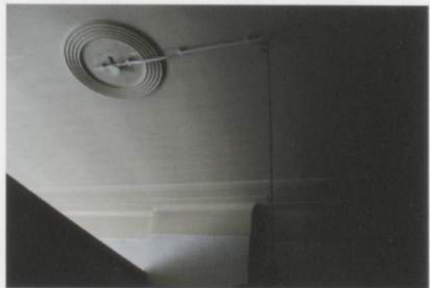
Voorkamer links 0.2, plafond met stookplaats
