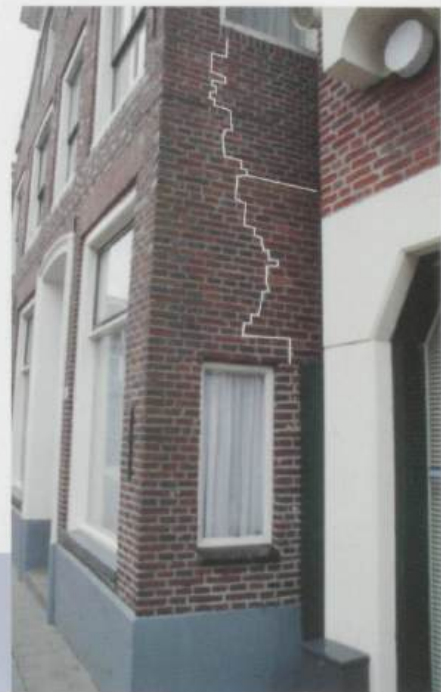
Verschillende steenformaten bij aansluiting voorgevel op zijgevel (foto auteur)
