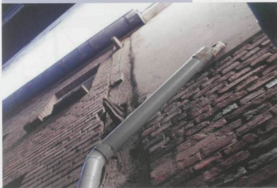
Rechterzijgevel met bouwfasen
