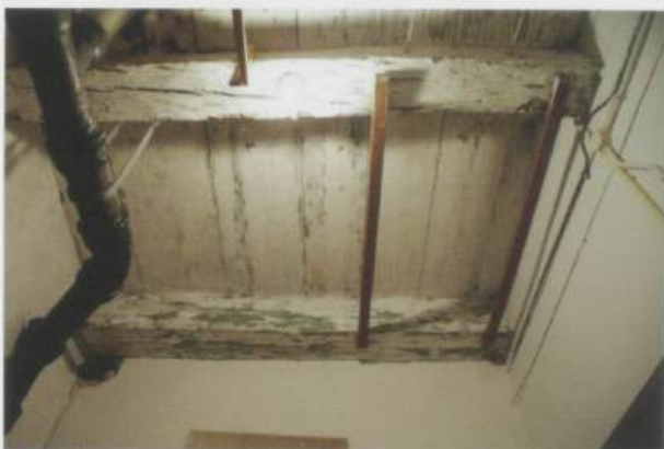
Tussenruimte 0.5 met balkenplafond (foto auteur)
