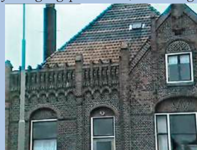
Detail metselwerk, kort voor sloop in 1989 (bron ZSOM Omroep Groenlo)
